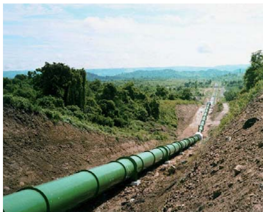
Tubería de impulsión de la estación de bombeo.
